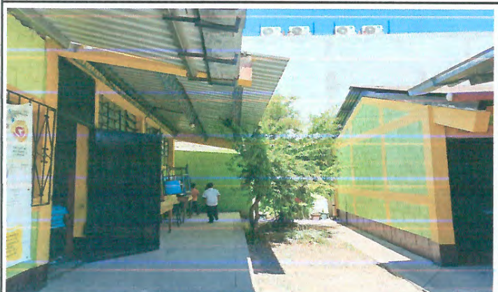
Foto 3: Mejoramiento de techo tipo pórtico
